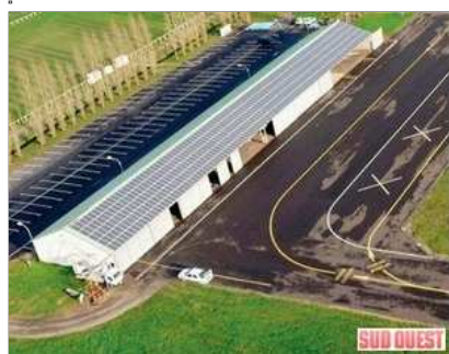
Les hangars de l'aérodrome sont désormais couverts par des panneaux solaires photovoltaïques. (photo DR)
